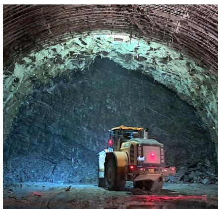
En 2025, le chantier CO7 a réalisé le montage complet du premier tunnelier, Viviana, lancé en septembre et qui a déjà parcouru presque 200 m vers l'est. À l'ouest, les excavations ont traversé une zone karstique de plusieurs centaines de mètres, avec des remplissages argileux rendant la progression complexe.
