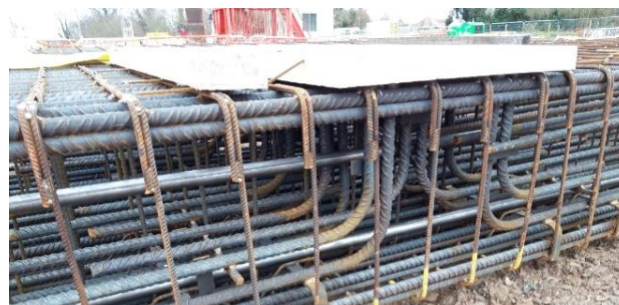
Figure 7. Panneau en polystyrène fixé à la cage d'armature (Piscsalko, 2022)
